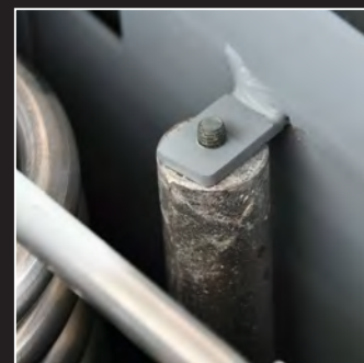
Magnesium-Schutzanode zum Schutz des Heizkessels
